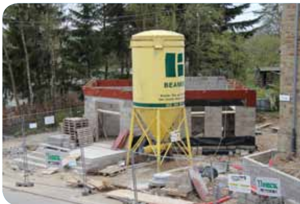
Bau der Totenkapelle Nidrum
